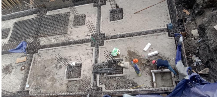
Kegiatan penulangan, pengecoran bagian GWT
