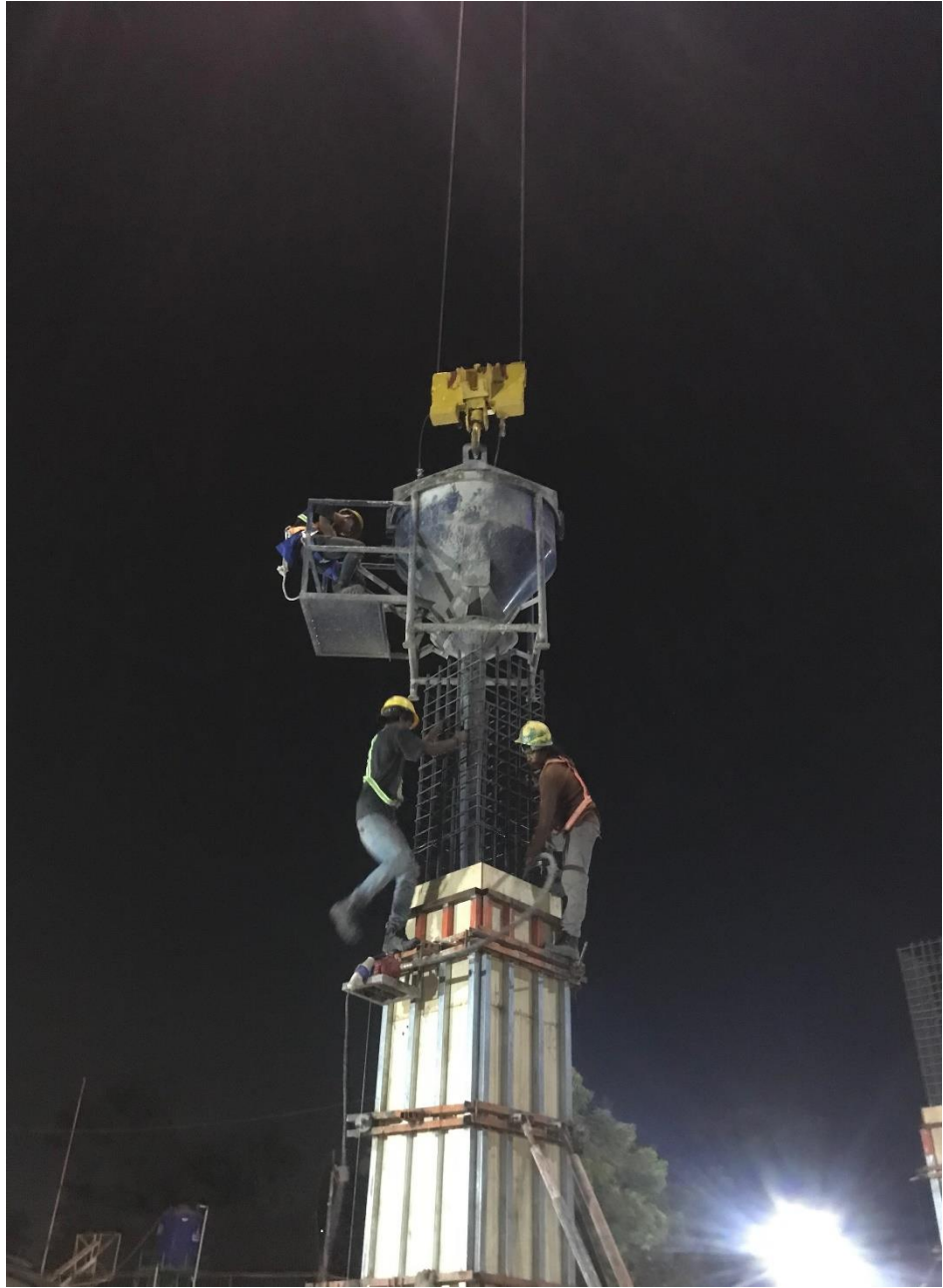
Kegiatan Pengecoran Pada Kolom
