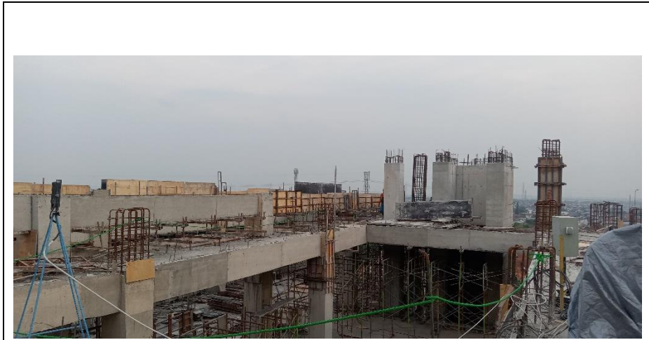
Kegiatan Pemasangan Bekesting pada Lantai Rooftop
