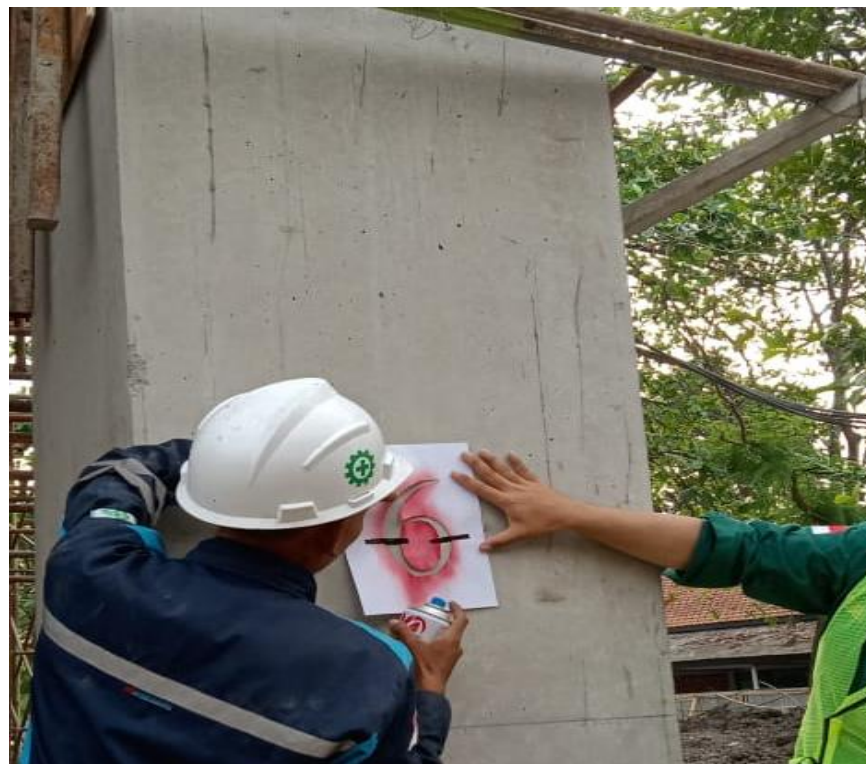
Kegiatan Leveling pada Kolom
