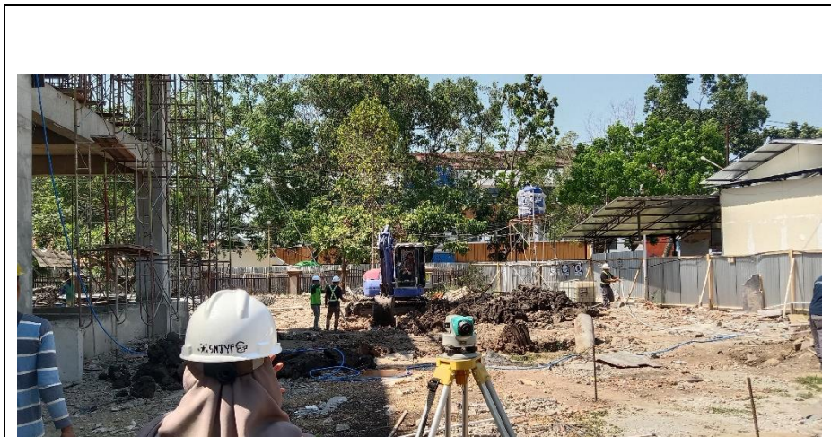
Kegiatan Pekerjaan Leveling untuk GWT
