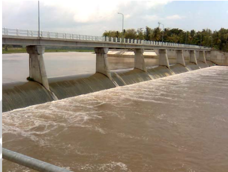
Foto 1. Lokasi Bendung Sapon (Kab. Kulon Progo, Prop. D.I.Yogyakarta)
