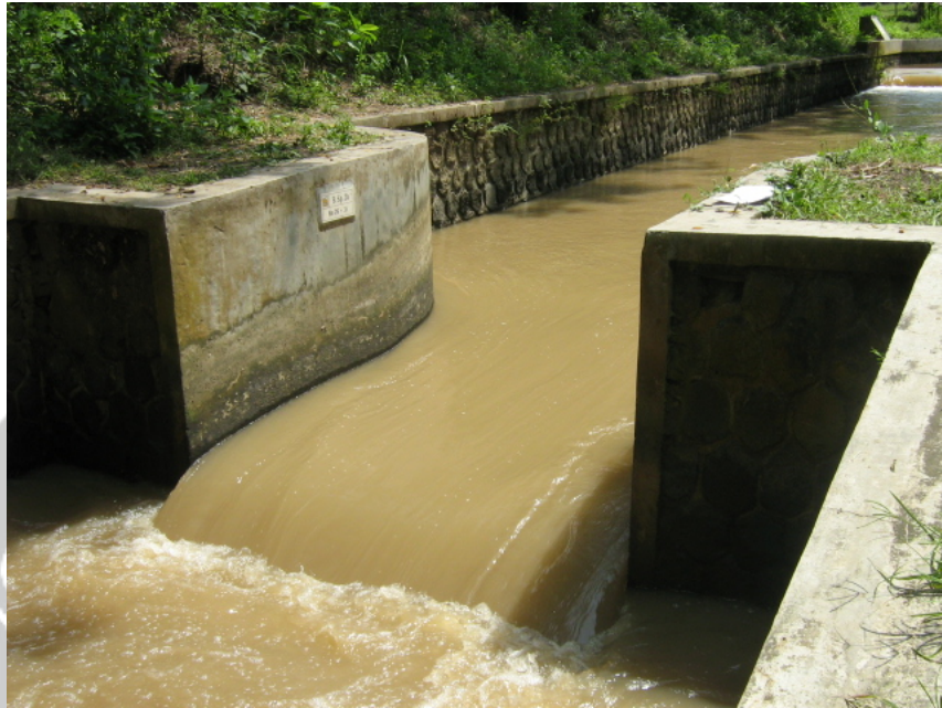
Foto 3. Alat Ukur Ambang Lebar di Saluran Primer Sapon II
