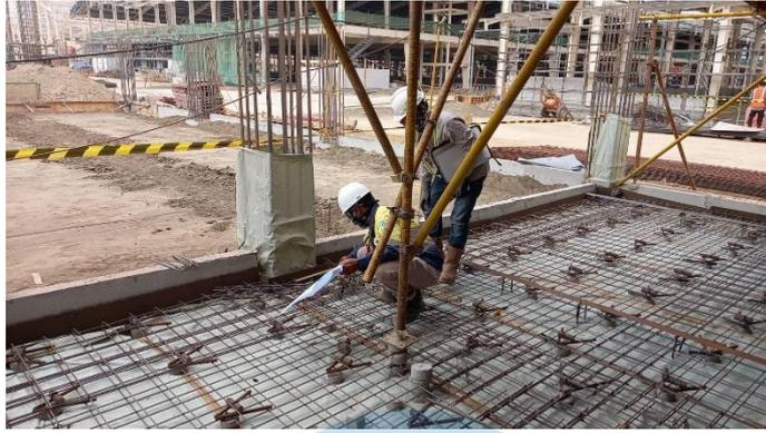
Gambar 2.10 Inspeksi proses pekerjaan pembesian pelat
