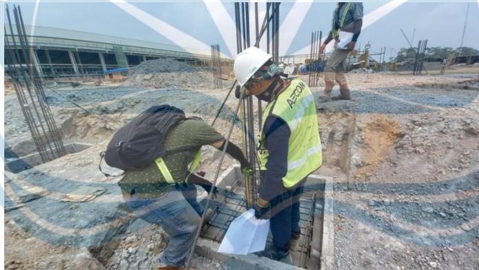
Gambar 2.9 Pengecekan top cor dari pilecap
