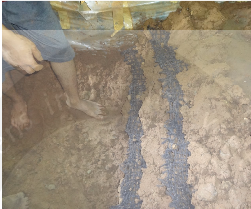
Gambar L.6 Peletakan 2 Lapis Anyaman Ijuk
