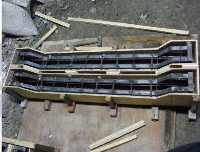
Gambar 1. Penempatan Rangkaian Baja Profil Siku Dalam Bekesting
