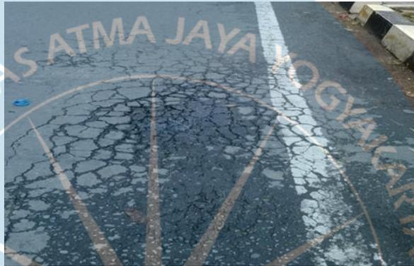
Gambar 2.3. Rusak Kulit Buaya (*Alligator Cracking*)
