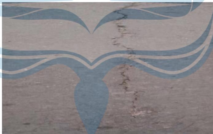
Gambar 2.11. Rusak Pinggiran Jalan Turun Vertikal (*Lane/Shoulder Dropp Off*)
