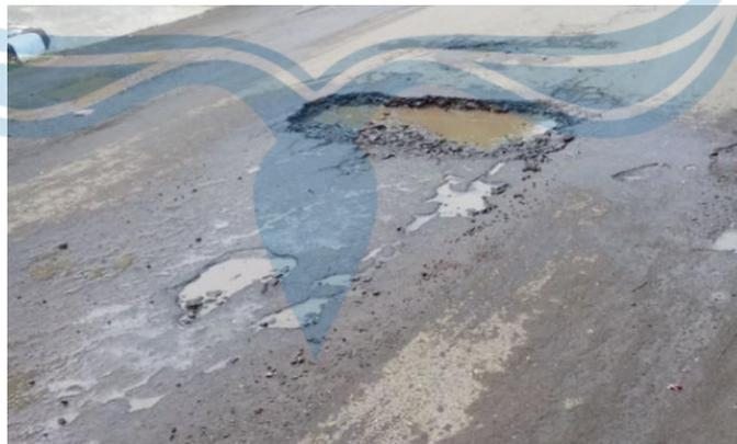
Gambar 2.15. Rusak Lubang (*Pothole*)
