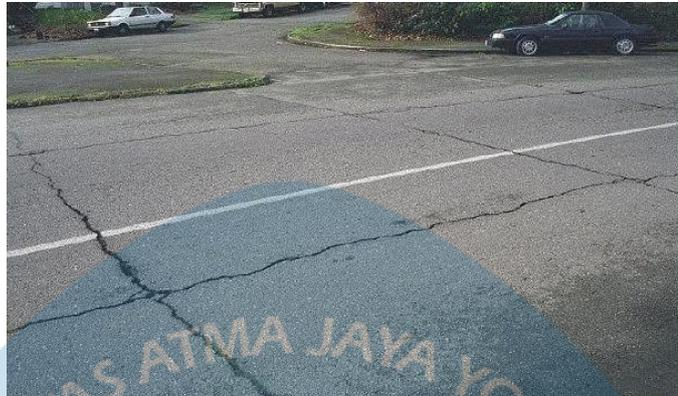
Gambar 2.10. Rusak Retak Sambung (*Joint Reflec Cracking*)
