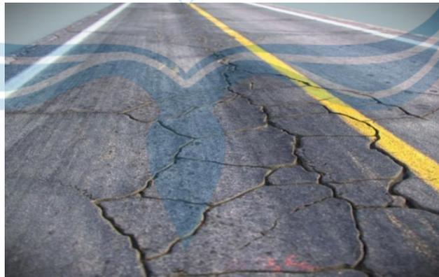
Gambar 2.5. Rusak Retak Kotak-kotak (*Block Cracking*)
