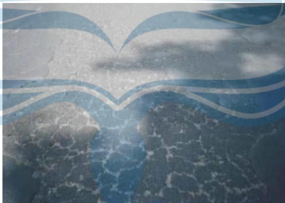
Gambar 2.21. Rusak Pelepasan Butir (*Weathering/Raveling*)
