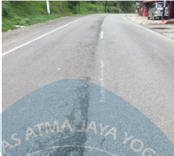
Gambar 2.12. Rusak Retak Memanjang/Melintang (*Longitudinal/ Trasverse Cracking*)
