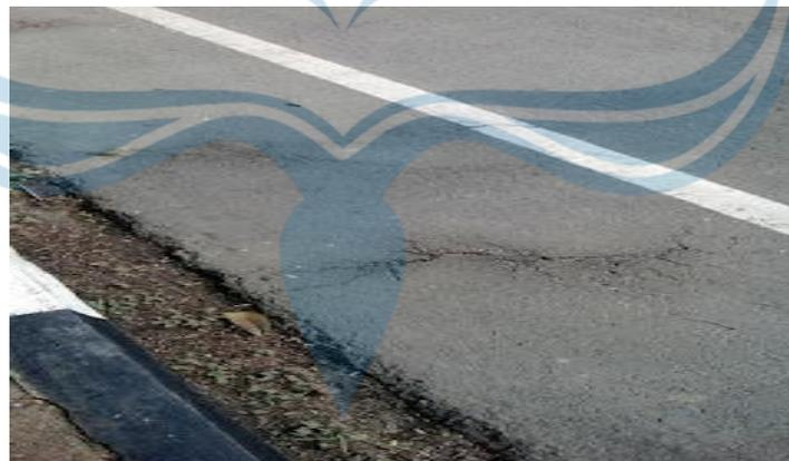
Gambar 2.9. Rusak Retak Samping Jalan (*Edge Cracking*)
