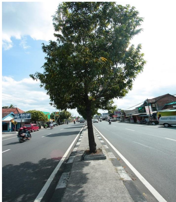
Foto 1.6 Kondisi Lapis Perkerasan pada Jalan Solo
