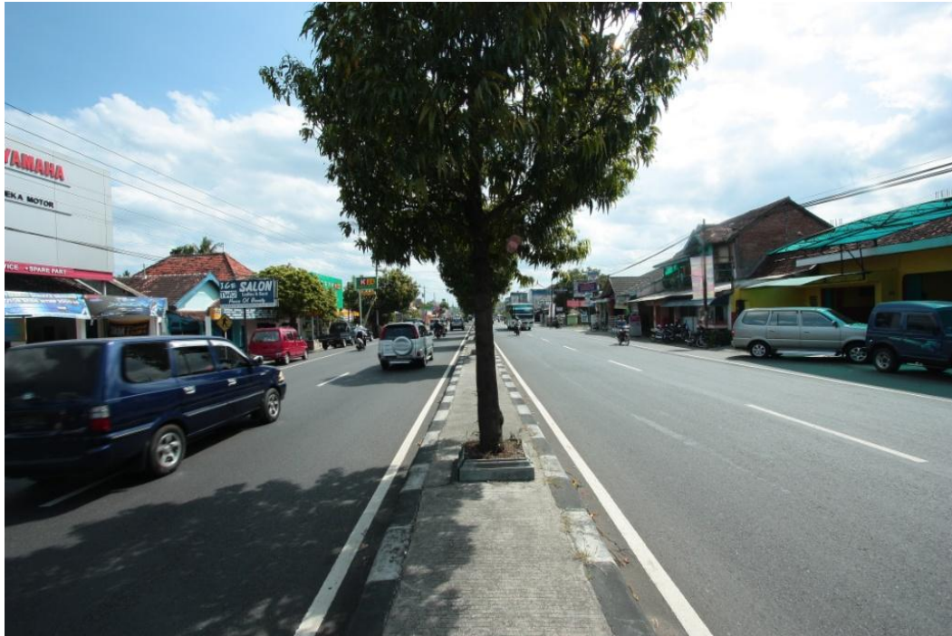
Foto 1.5 Kondisi Lapis Perkerasan pada Jalan Solo
