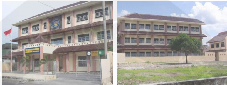
Gambar 1 : Tampak Depan dan Samping Bangunan SD Muhammadiyah Condong Catur
