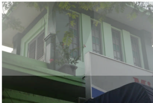
Gambar 2.42 Jendela dan Kolom Pada Lantai Dua Bangunan Cagar Budaya
