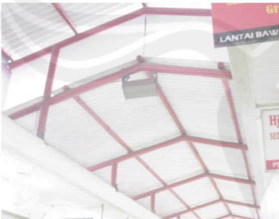
Gambar 2.52 Struktur Atap Asbes Sumber : Koleksi Penulis, 2012
