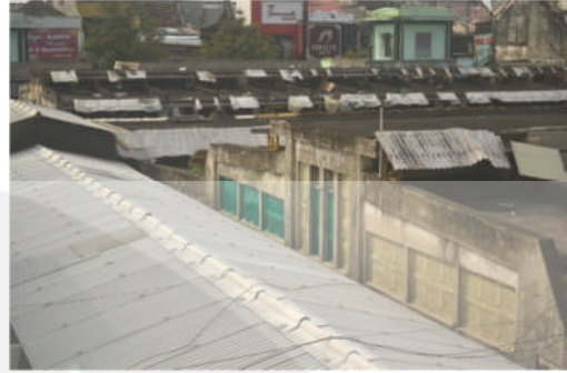
Gambar 2.50 Atap Bangunan Cagar Budaya Berpadu dengan Atap Baru Dari Bahan Plastik Sumber : Koleksi Penulis, 2012
