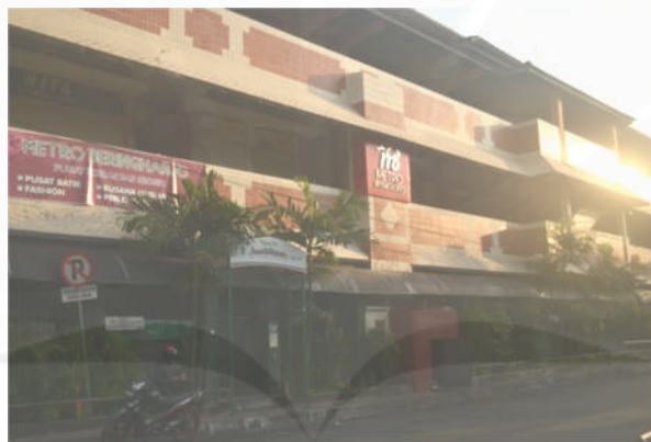
Gambar 2.12 Tampak Utara Pasar Bringharjo Tengah Sumber : Koleksi Penulis, 2012
