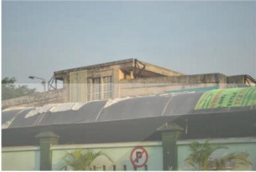
Gambar 2.50 Atap Bangunan Cagar Budaya Berpadu dengan Atap Baru Dari Bahan Plastik Sumber : Koleksi Penulis, 2012
