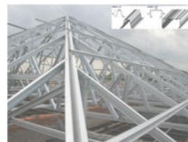
Gambar 6.10 Rangka Baja Ringan
