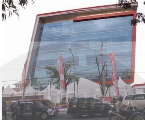
Gambar 1.1 *Telkomsel building Makassar* dengan kemiringan  $5^{\circ}$
