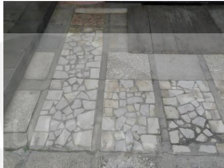
Gambar 2.23 Detail Lantai dengan Ubin Sisa di Wisma Kuwera
