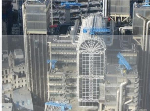
**Gambar 3.17. Crane pada puncak bangunan *Lloyds Building***
