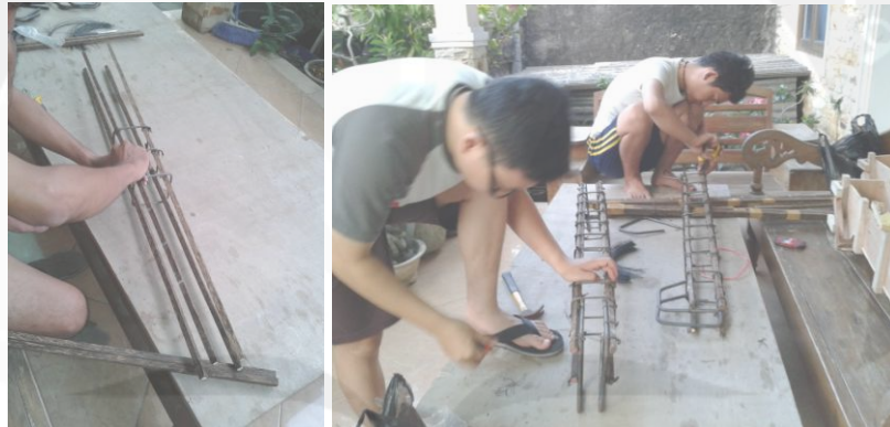
Gambar 5. Perakitan Tulangan Kolom
