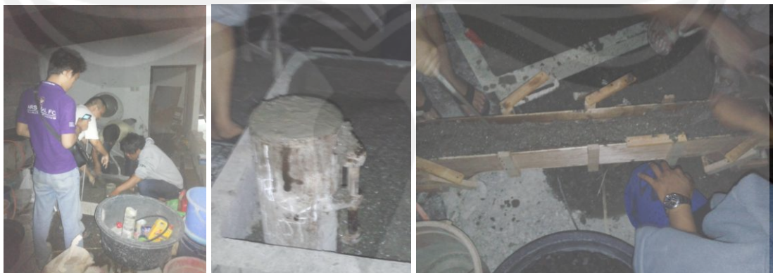
Gambar 6. Pengecoran Silinder dan Kolom
