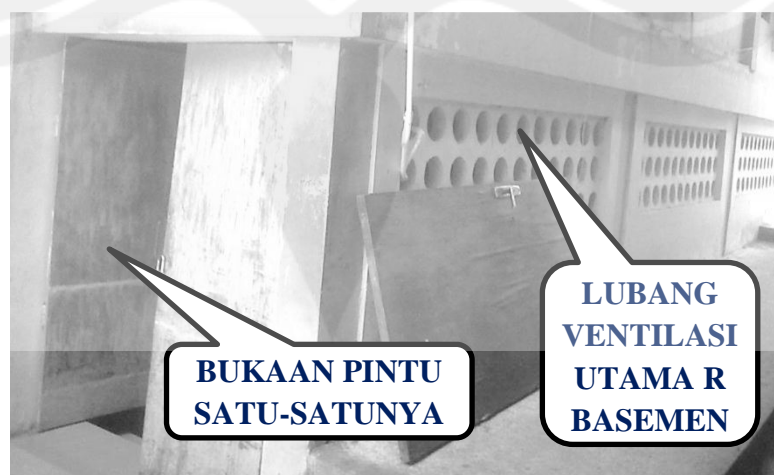
Gambar 5. Ventilasi utama sisi barat ruang “basemen” (foto: penulis)
