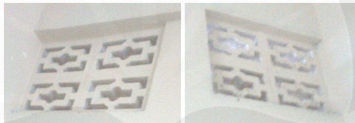
Gambar 4. Ventilasi di sisi lain sudut timur dan barat laut. (foto: penulis)
