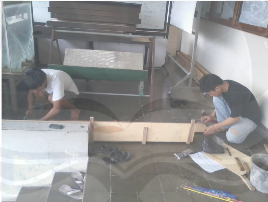
Gambar Pembuatan Bekisting Balok
