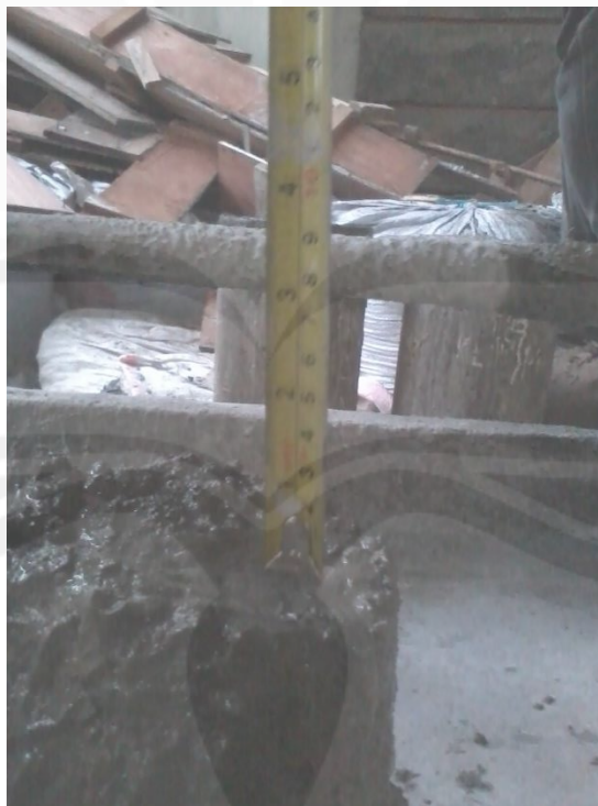
Gambar Pengujian Slump
