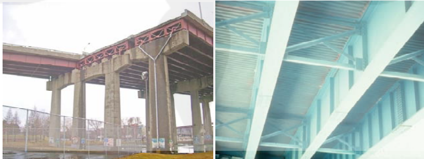
Gambar 2.3. Jembatan baja multi girder I.
