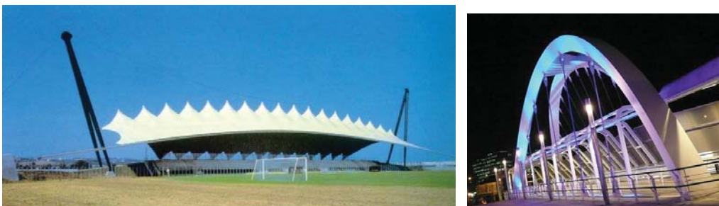
Gambar 93: Sistem Kabel yang Digunakan Pada Tribun Penonton
