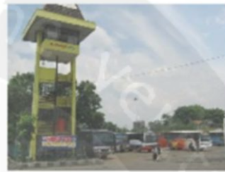
Gbr. Menara Pengawas
