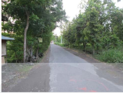
Gambar 3. 9 No 1 Kondisi Jalan Tegal Mlati
