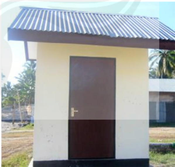
Rumah Pompa Tahun 2011
