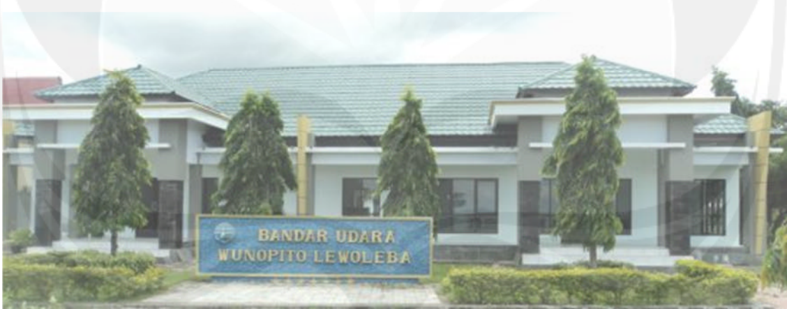
Terminal Domestik 300 M 2 (30x10) Tahun 2012 (Renovasi) Rp. 1.026.250.000,-
