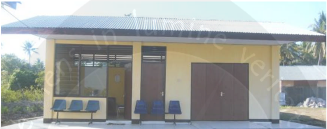
Gedung Power House 24 M 2 (6x4) Tahun 1994 Rp. 9.595.000,- Renovasi 2011 Rp. 57.600.000,-
