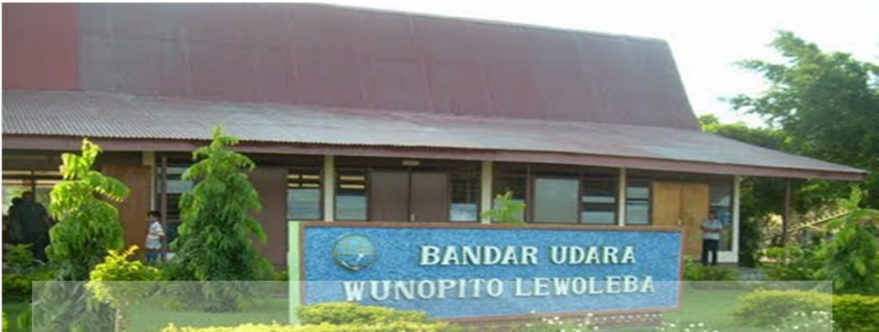
Gedung Terminal 1994 yang belum direnovasi
