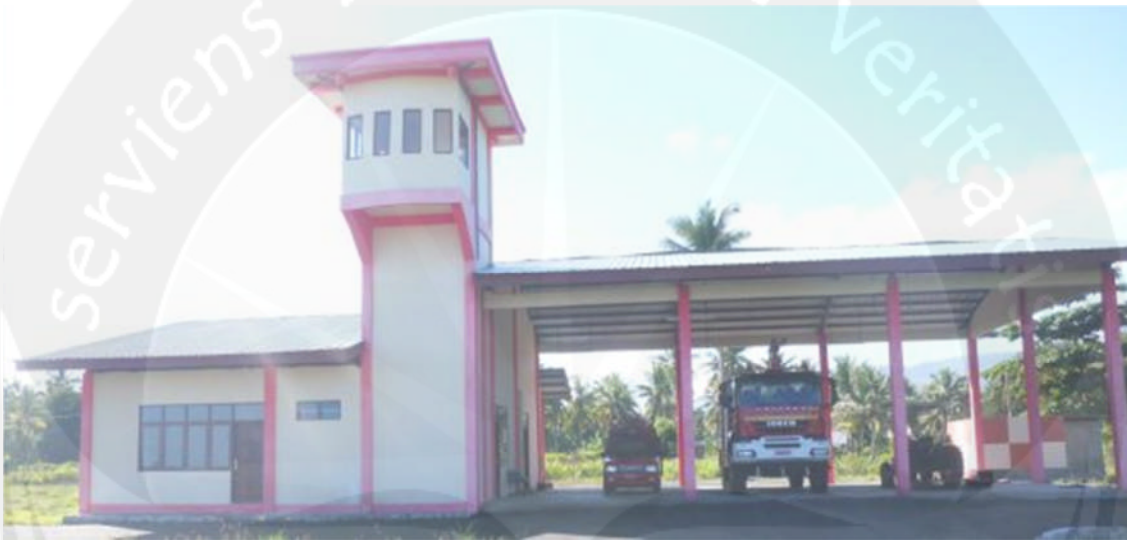
Gedung PKP-PK 300 M 2 (30x10) Tahun 2012 Rp. 1.154.779.000,-
