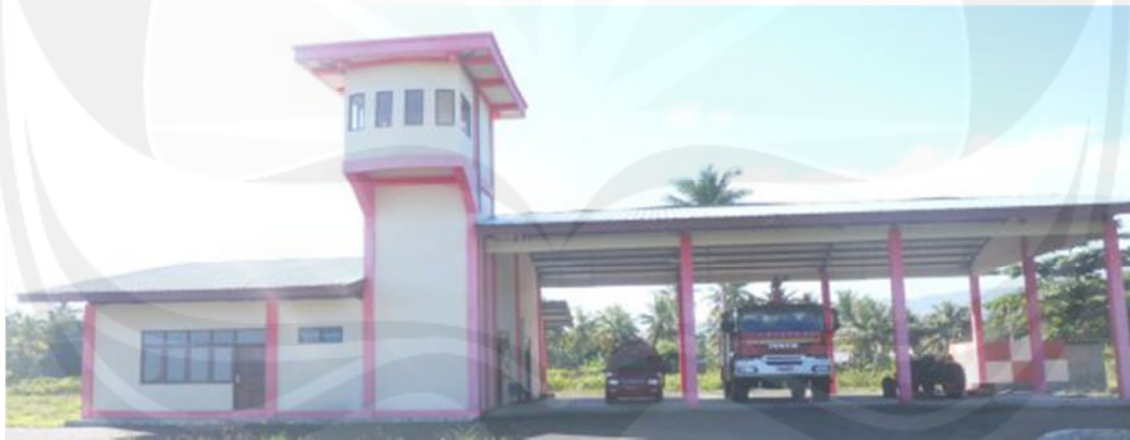
Gedung PKP-PK 300 M 2 (30x10) Tahun 2012 Rp. 1.154.779.000,-
