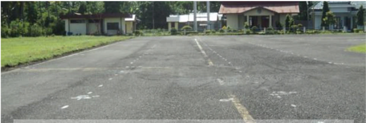
Permukaan Taxiway sebelum overline
