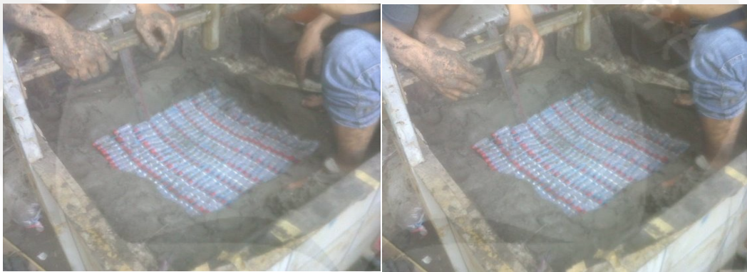
Pemasangan 2 Lapis Perkuatan Botol Plastik Yang diisi Pasir
