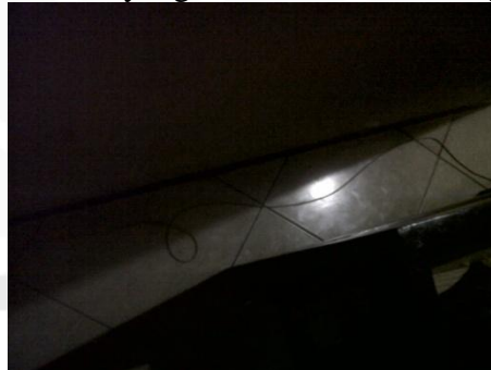
Gambar 12 Kabel yang Berserakan di Lantai
