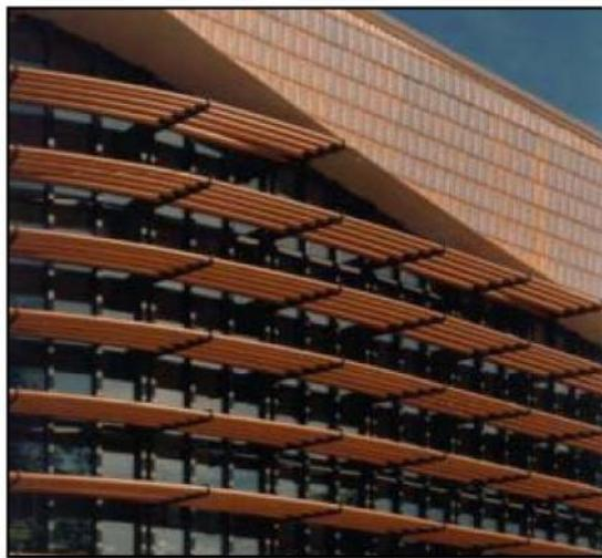
*Gambar 2.9 Fasad bangunan berupa pelindung matahari aluminium*
