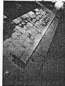
Tepi bangunan ( lining ) di halaman dalam/ belakang
