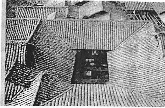
Gambar 3.4 Tian jing 天井 tampak atas . Skywell , untuk pencahayaan siang hari, ventilasi dan menampung air hujan. (Knapp. 2006: 25).
