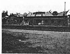
Bangunan tambahan 1970an di sisi timur klenteng.
