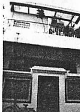
Sayap kanan, bangunan tambahan bertingkat
