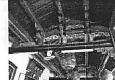
Plafond melengkung bai-ting , 拜亭 ruang pendopo
