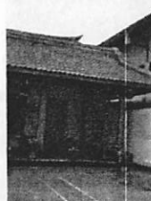
Tidak ada, sisi teras 2009, 2013
