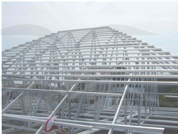
Gambar 6.3 Rangka atap baja ringan
