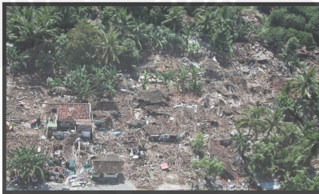
Gambar 1.1. Kerusakan akibat Gempa di suatu kampung di Bantul, Jogja, Mei 2006 ( http://www.littlecare.org/ind/proyek.html , diakses tanggal 17 Desember 2012)
