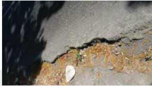
Gambar 2.5. Kerusakan Penurunan Bahu Jalan
