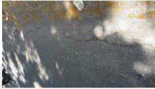
Gambar 2.6. Kerusakan Retak Memanjang dan Melintang
