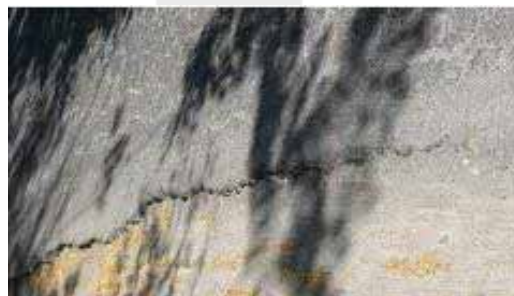
Gambar 2.3. Kerusakan Cacat Tepi Perkerasan
