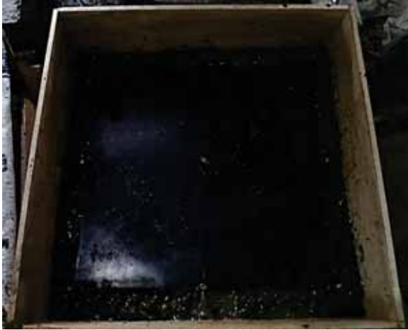
Gambar L4.9. Foto Peletakan Pelat Baja Saat Pengecoran
