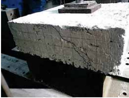
Gambar L4.13. Foto Retak pada Pelat PL1B Setelah Diuji
