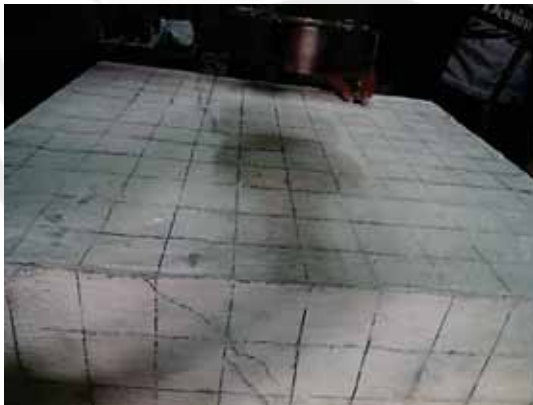
Gambar L4.15. Foto Retak pada Pelat PL2A Setelah Diuji
