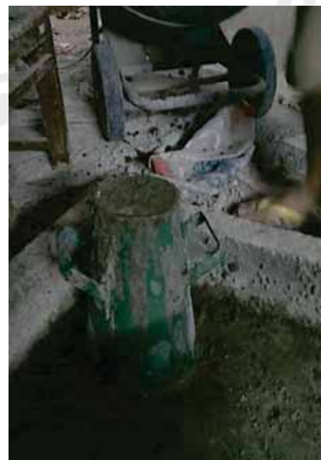
Gambar L4.4. Foto Pengujian Slump
