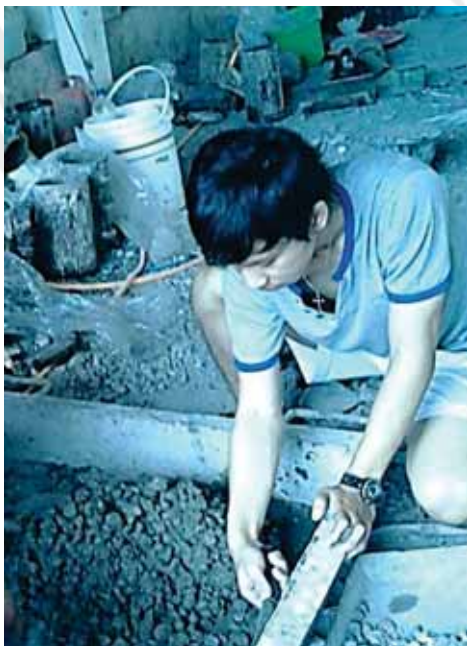
Gambar L4.3. Foto Pencampuran Adukan Agregat
