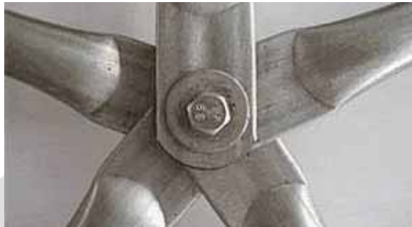
Gambar 2.6. Sambungan baut penopang baja profil pipa
