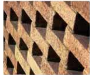
Sebagian besar dinding akan menggunakan roster, untuk menciptakan sirkulasi udara yang baik dalam ruangan.
