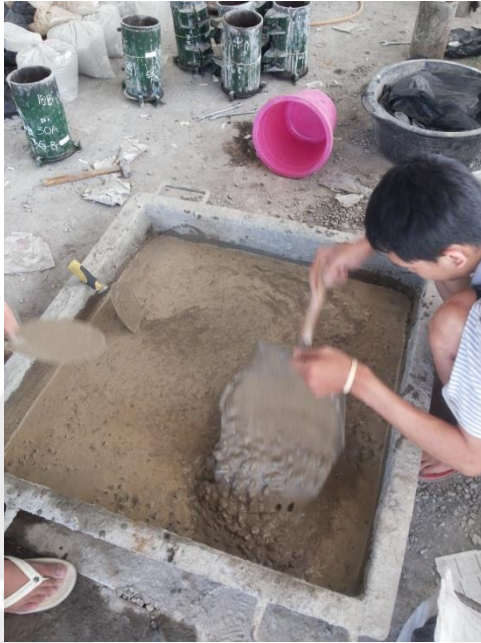
Pembuatan Campuran Adukan Beton
