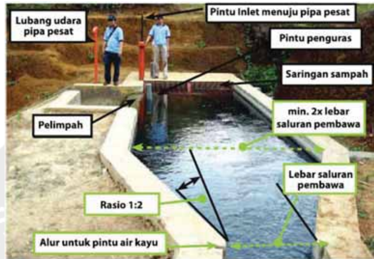
Gambar 2.5 Contoh yang ideal untuk bak pengendap ( forebay ).
