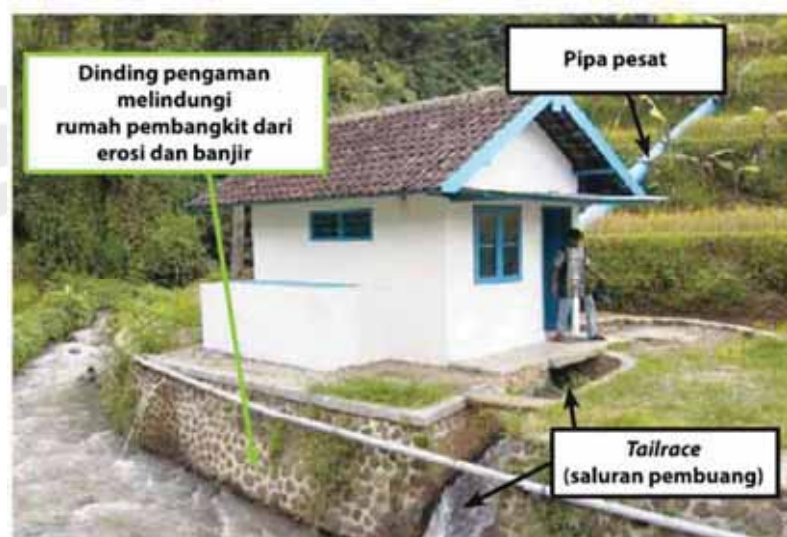
Gambar 2.7 Contoh yang ideal untuk rumah pembangkit
