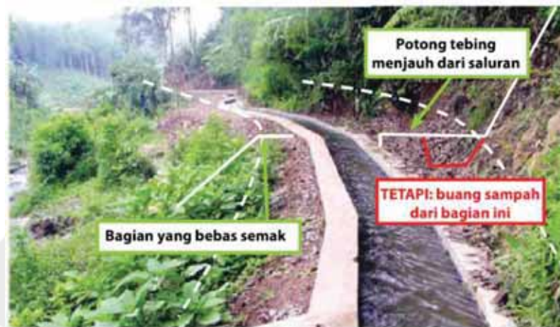
Gambar 2.4 Contoh yang ideal untuk saluran pembawa
