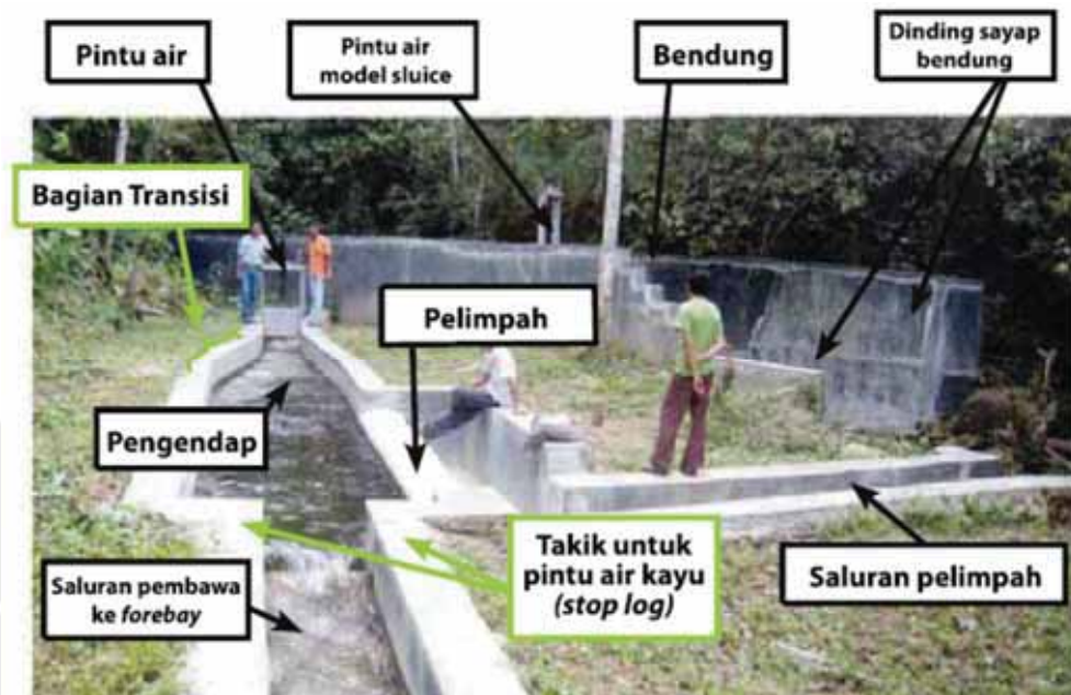
Gambar 2.3 Contoh yang ideal untuk bendung, intake , pengendap, dan bangunan lainnya
