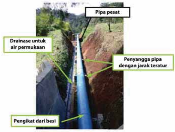
Gambar 2.6 Contoh yang ideal untuk penstock
