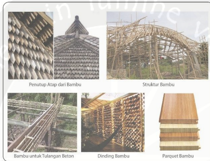
Gambar 5.12 Pemanfaatan Bambu sebagai Bahan Bangunan
