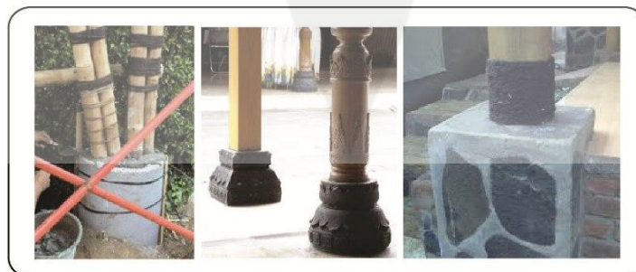
Gambar 5.23 Pondasi Titik untuk Bambu dan Kayu
