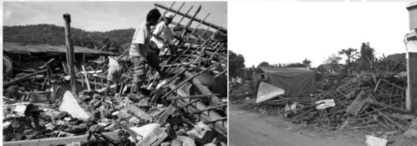
Gambar 1.4 : Kerusakan di Pasar Imogiri
