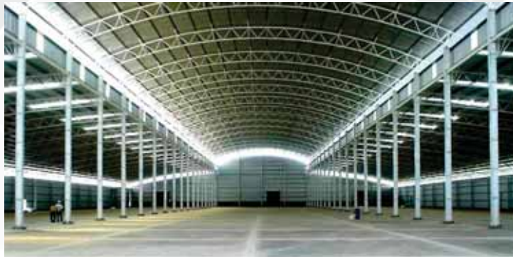
Gambar 2.21 Ilustrasi Struktur Rangka Atap Menggunakan Struktur Baja Ringan
