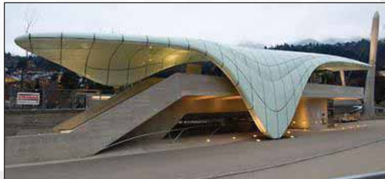
Gambar 2.29 Loewenhaus Station, Satu dari Empat Stasiun di North Park Cable Way
