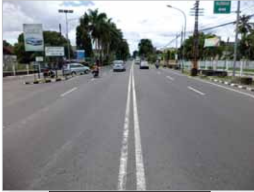
Foto Sebelum Median Ruas A
