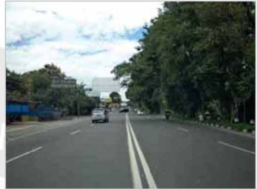
Foto Sebelum Median Ruas A
