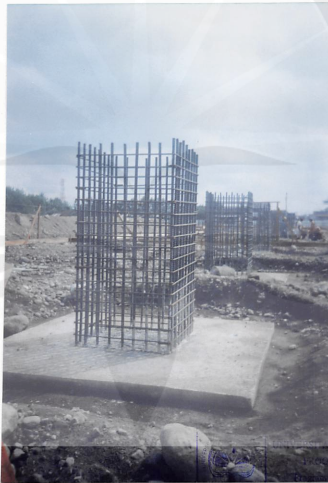
Lampiran foto 4.8. Pile cap
