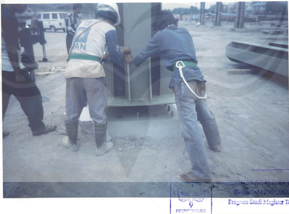
Lampiran foto 4.14. Erection kolom baja king cross
