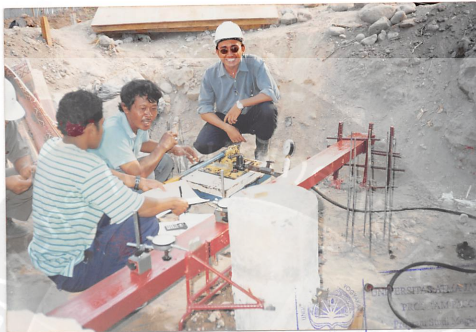
Lampiran foto 4.5. Pengujian tiang pancang
