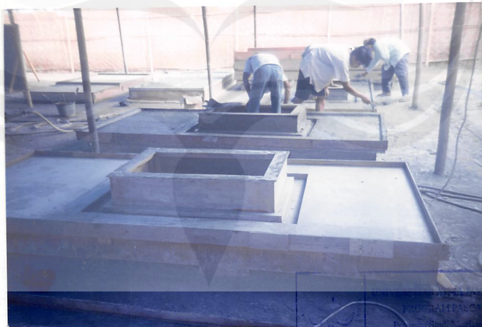
Lampiran foto 4.18. Fabrikasi GRC cetak
