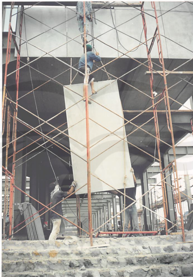
Lampiran foto 4.20. Erection GRC cetak
