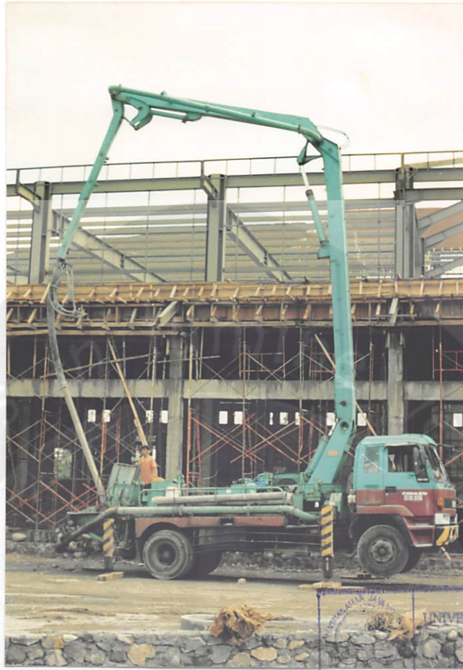
Lampiran foto 4.37. Pencoran pelat lantai dua dengan concrete pump
