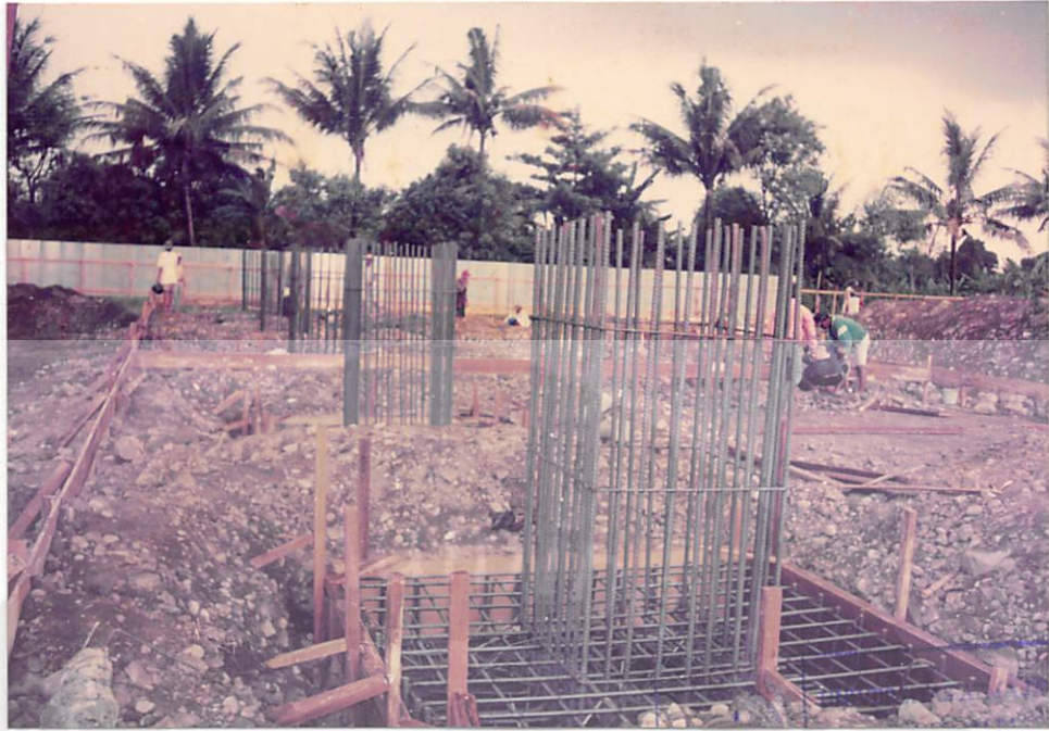
Lampiran foto 4.7. Penulangan pile cap
