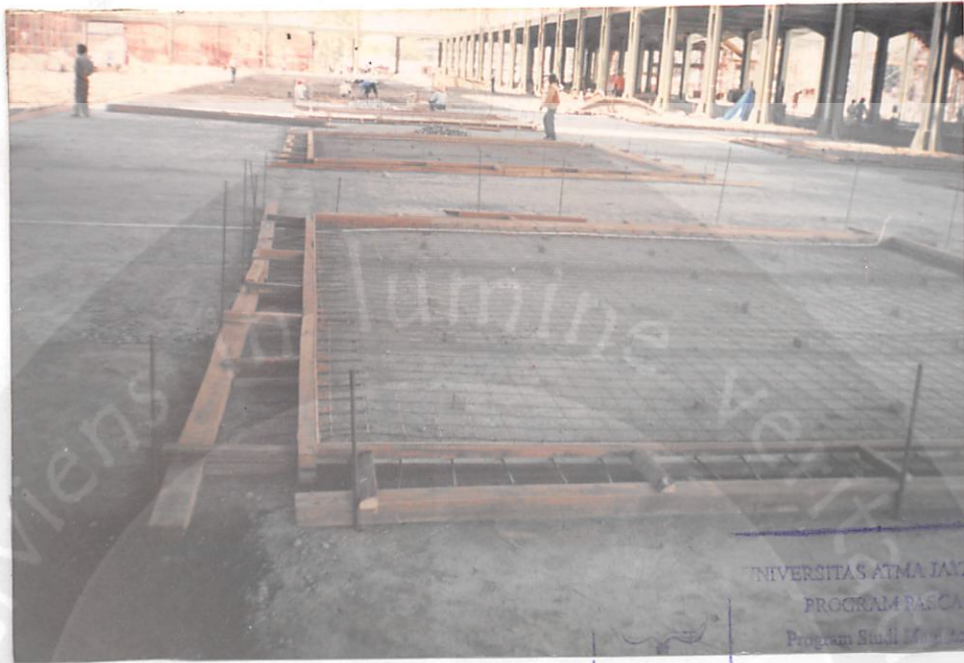
Lampiran foto 4.27. Penulangan lantai satu
