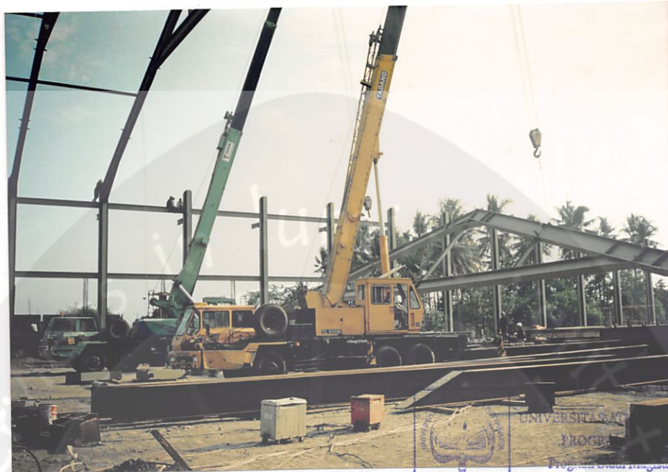
Lampiran foto 4.39. Erection kuda-kuda baja
