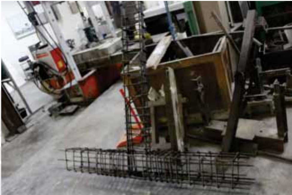
Tulangan yang siap dipasang
