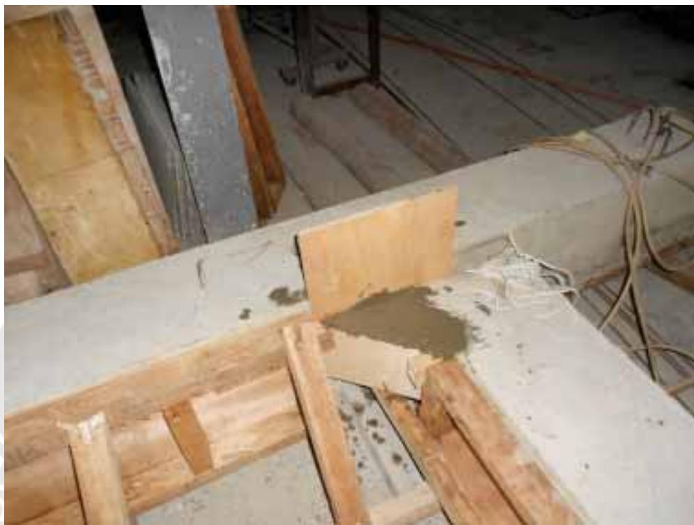
Dasar pengecoran perkuatan spesimen 2 (SJ02)
