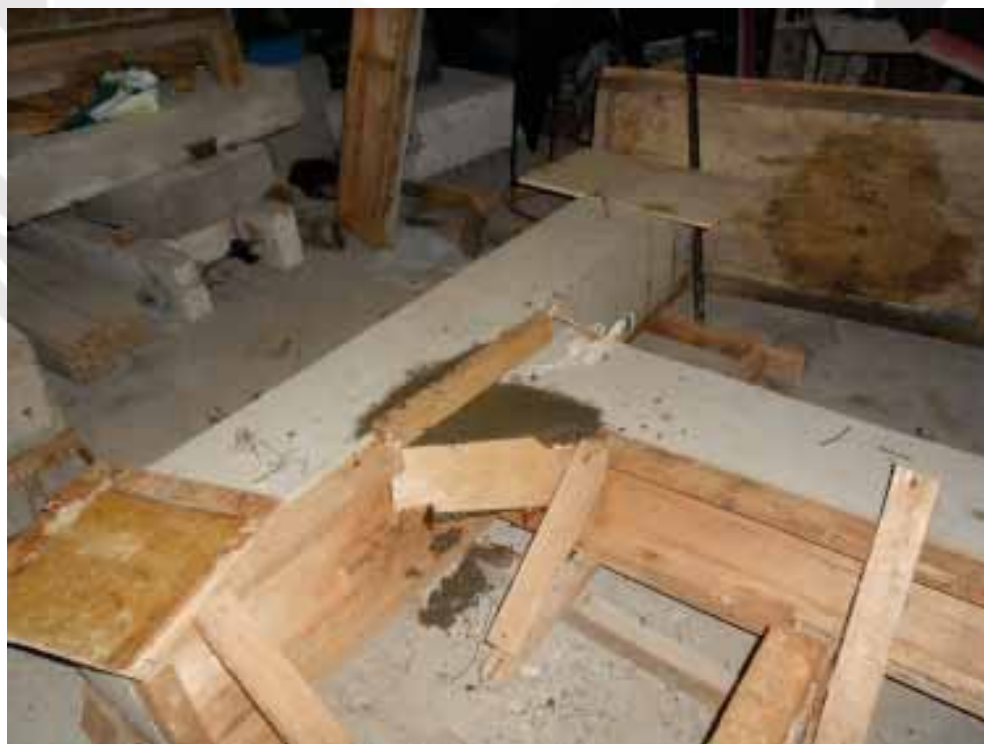
Dasar pengecoran perkuatan spesimen 3 (SJ03)
