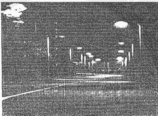
Gambar 3.10 Instalasi Penerangan Jalan Dengan Susunan *staggered*
