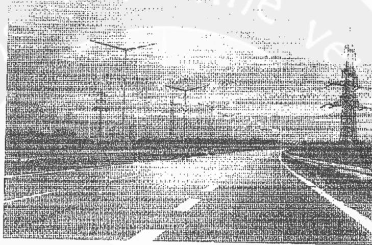
Gambar 3.13 Instalasi Penerangan Jalan Dengan Susunan *Twin center*
