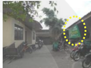
Gbr I.11. Kondisi Kios Sepeda yang Berubah Menjadi Warung Makan Foto: Survei Lapangan, Juni 2011
