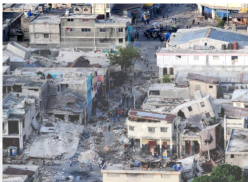
Gambar 2.1 Kehancuran fasilitas akibat Gempa bumi di Haiti
