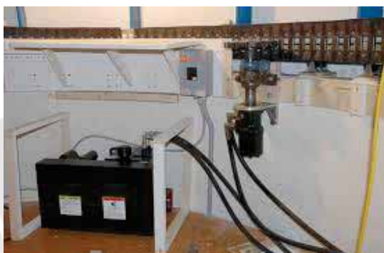
Gambar 2.25: motor listrik pada dome
