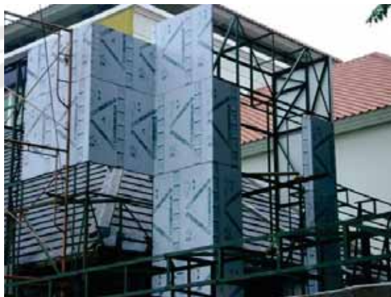
Gambar 4.11.pemakaian modul rangka struktur tefabrikasi pada bangunan
