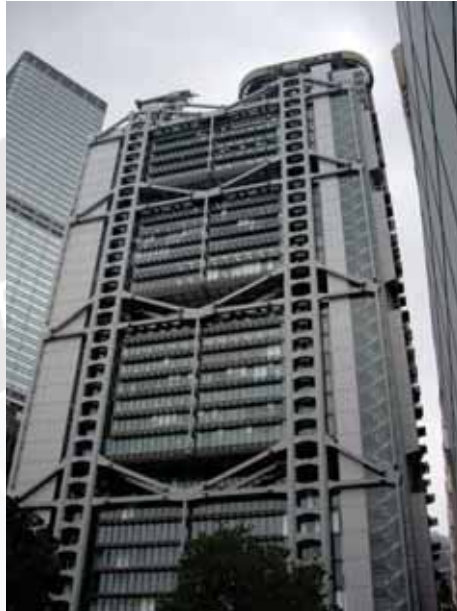
Gambar 4.9. pemakaian kolom baja sebagai struktur utama bangunan Shanghai and Hongkong Bank karya Norman foster
