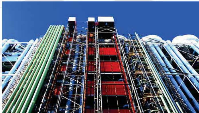
Gambar 4.8. pemakaian warna yang berbeda untuk membdakan jenis sturktur dan utilitas
