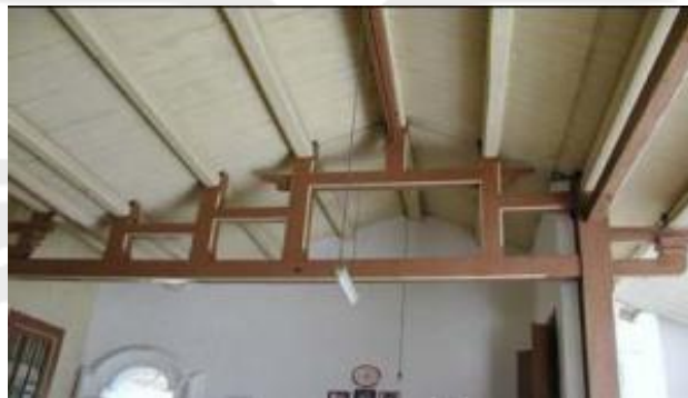
Gambar 4.17: Kuda-Kuda Segi Empat pada Rumah Tionghoa Peranakan Sumber: Handinoto, 2008
