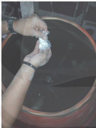
Mencampur serat dalam adukan beton
