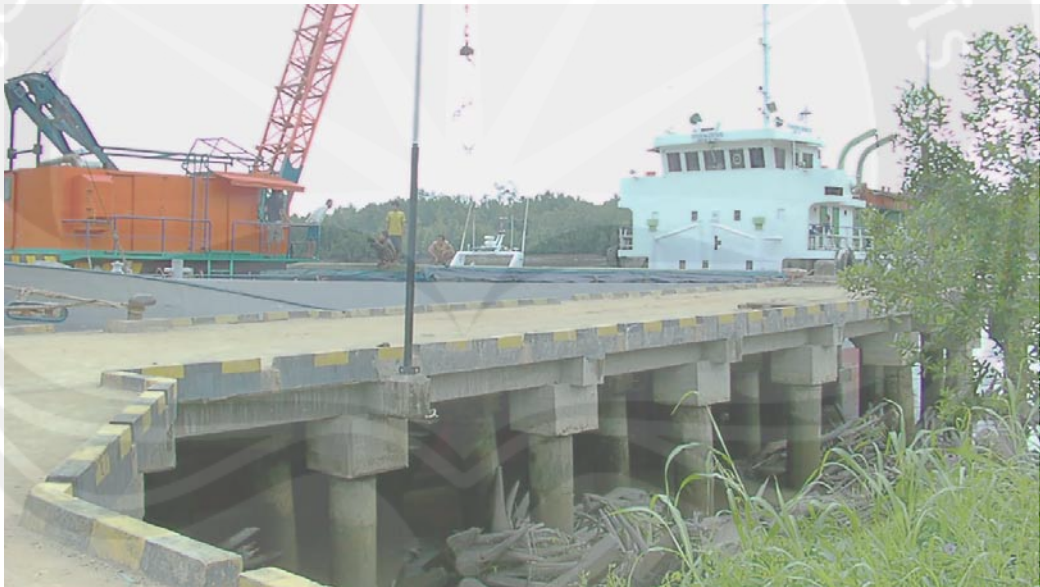
Kondisi eksisting pelabuhan Bintuni
