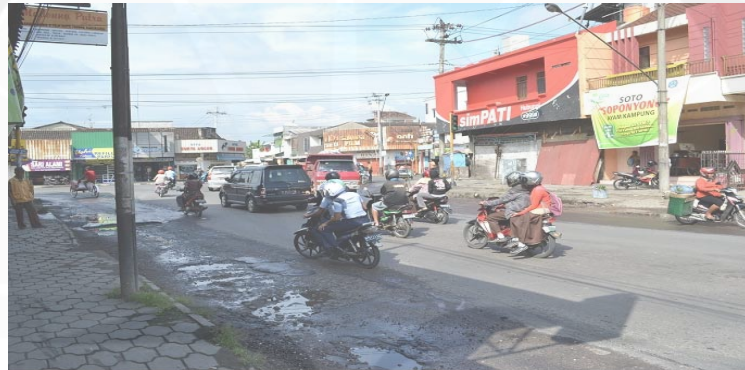
Gambar 1.4. Kondisi Jalan Adi Sumarmo Yang Rusak (Sumber : Penulis, 18 Mei 2011)
