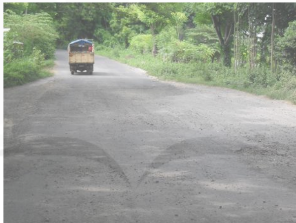
Kerusakan Jalan Pada STA 0+200
